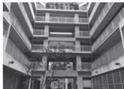
A棟の内側。吹き抜けのようなデザインの建物です。
